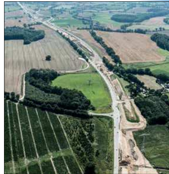
Standortübergreifende Bearbeitung beim Ausbau der B 404 zur Autobahn A 21.
